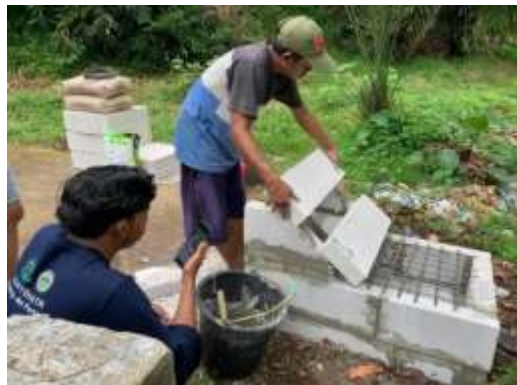
Gambar 2. Tahap pembuatan Rocket Stove
